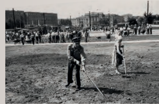
Prace porządkowe na pl. Dzierżyńskiego. W tle odbudowany pałac Mostowskich, siedziba Komendy MO m.st. Warszawy, 1963
