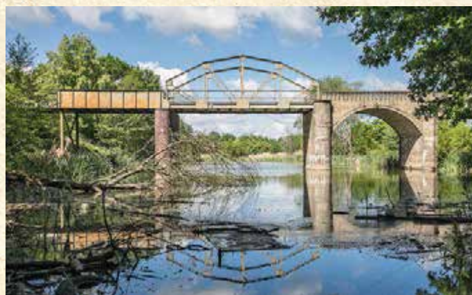
Ćwiczebny mostek saperski. Zachowały się otwory i komory pod ładunki wybuchowe. Włazy zostały zabezpieczone
