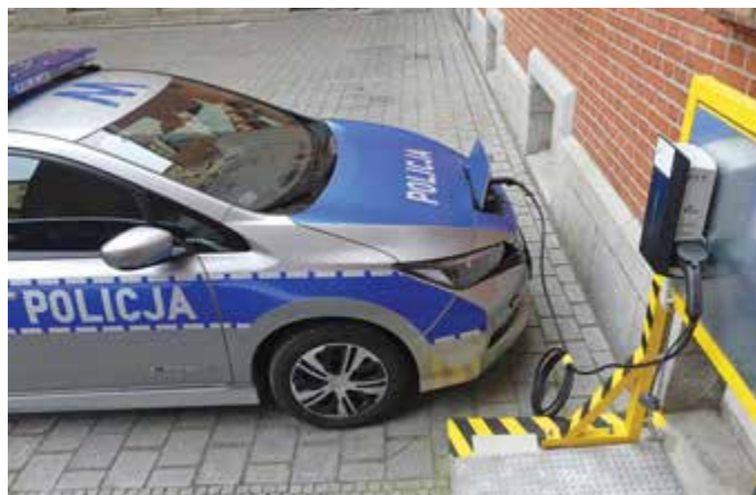
Stacja szybkiego ładowania samochodów elektrycznych na dziedzińcu KWP w Szczecinie
