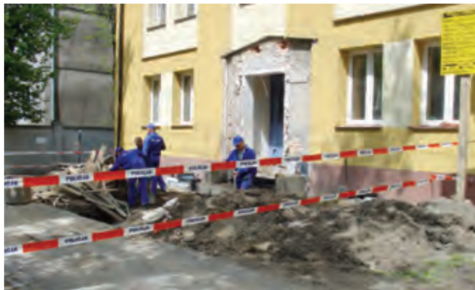
Remont budynku komendy pruszkowskiej policji
