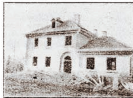
Jeden ze znajdujących się obecnie w trakcie budowy budynków — dla posterunku P. P. w Ostkach, woj. poleskie (typ zasadniczy — z pomieszczeniem dla 4 skoszarowanych)!
