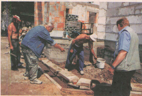
Budowa hoteliku idzie pełną parą
