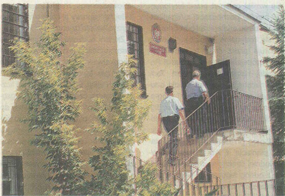
Ciasny, ale własny – tak można by określić siedzibę ślesieńskich funkcjonariuszy. Typowy projekt z lat 70. nie odpowiada unijnym standardom, ale jest zadbane i ładnie wkomponowany w zieleni
