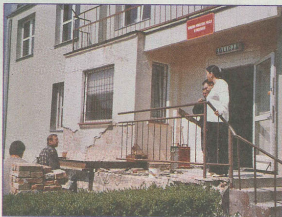
Prace remontowe przez kilka miesięcy utrudniały funkcjonowanie komendy. 24 lipca, w dniu Święta Policji, nastąpiło oficjalne oddanie wyremontowanego obiektu do użytku
