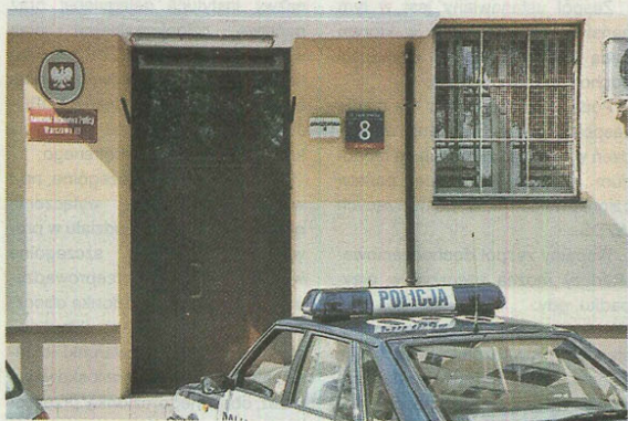
W jednostce przy Opaczewskiej już wkrótce rozpoczną się prace remontowe
