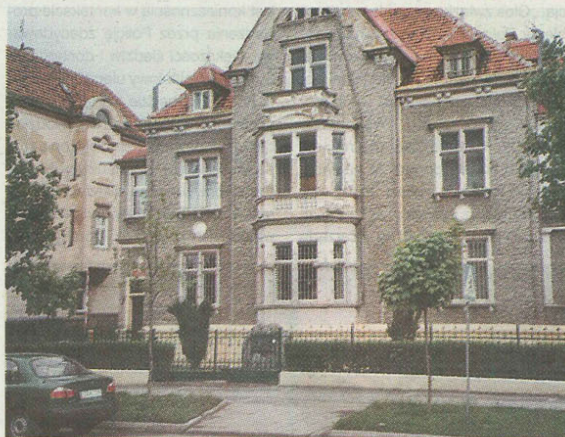
Zabytkowy budynek komendy etapami przechodzi kolejne remonty. W tym roku czeka go remont dachu
