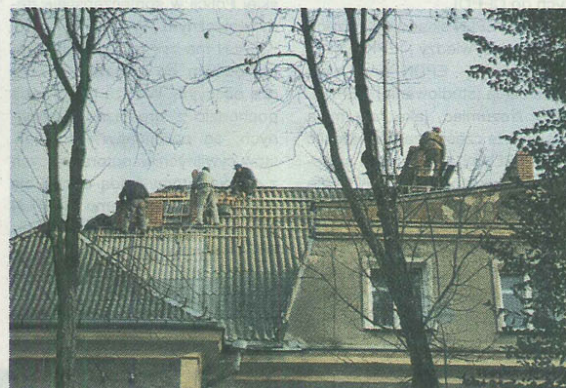
Remont dachu na budynku sejneńskiej policji
