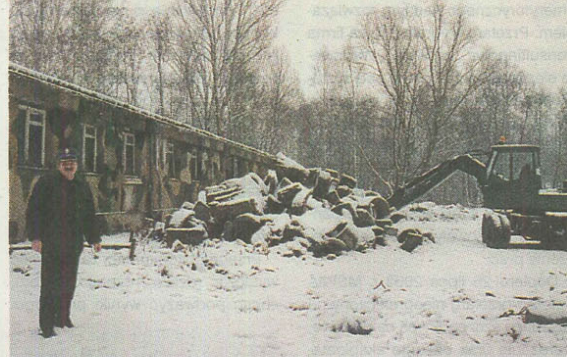
Pozostałości po remoncie
