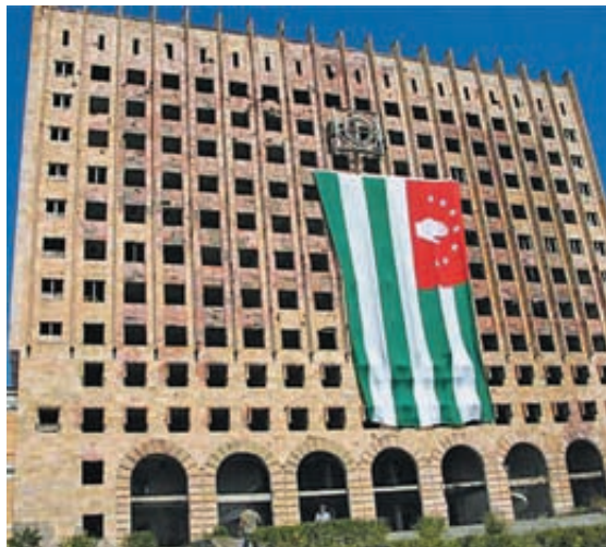
Po tym budynku zostały tylko ściany
