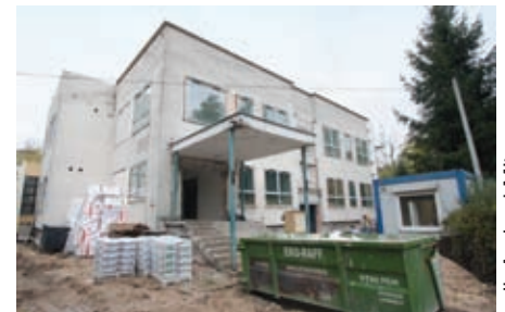
Prace remontowe trwają
